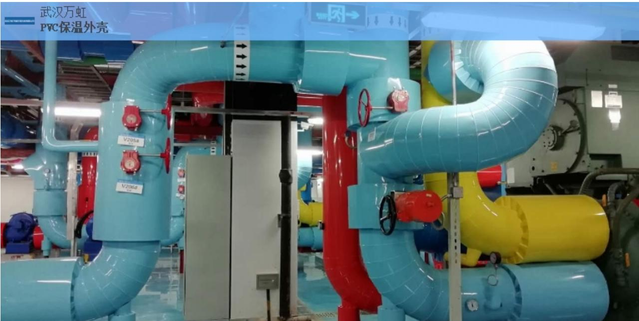
壳乐斯·彩壳·橡塑，橡塑保温材料具有很高的弹性，能很大限度地减少冷冻水和热水管道在使用过程中的振动和共振。
